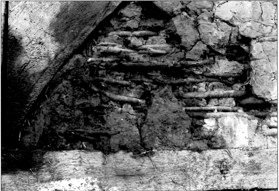
Regesbostel 1983: Lehmfachwerk im Nordgiebel
