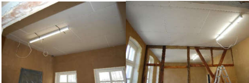
20) Heizung wurde in drei Räumen installiert. ( Fa. Schünzel )
