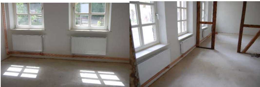
21) Malerarbeiten wurden abgeschlossen. ( Fa. Best. )
