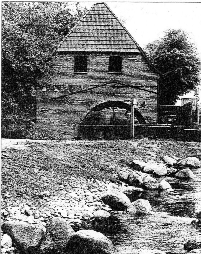
An der Holmer Mühle haben es Fische künftig bequem: Sie wandern über die Aufstiegshilfe flußaufwärts Foto: rai
