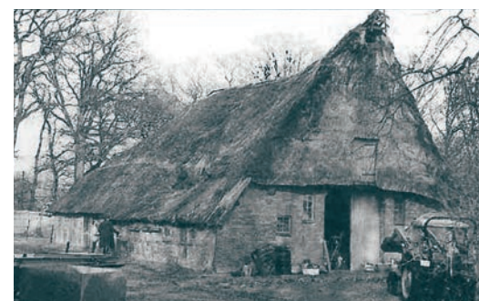
Zustand des Hauses 1983. Für die Restaurierung des Strohdaches waren schon seit Anfang des letzten Jahrhunderts keine Mittel mehr vorhanden gewesen. Lediglich die Grot Dör und deren Giebel wurden 1938/39 erneuert und wegen der Einsturzgefahr mit Mauerwerk unterfangen.
