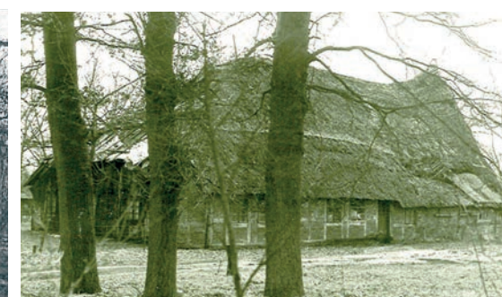
Zustand des Hauses 1983. Für die Restaurierung des Strohdaches waren schon seit Anfang des letzten Jahrhunderts keine Mittel mehr vorhanden gewesen. Lediglich die Grot Dör und deren Giebel wurden 1938/39 erneuert und wegen der Einsturzgefahr mit Mauerwerk unterfangen.
