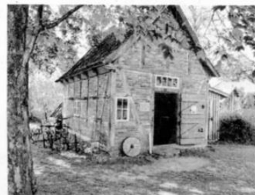
Das Backhaus auf dem Gelände des Museumsdorfes Seppensen
