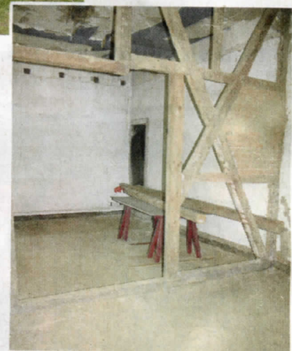
Überraschung: Bei den Vorarbeiten stellte sich heraus, dass der Boden im alten Ausstellungsraum gar nicht fest war
