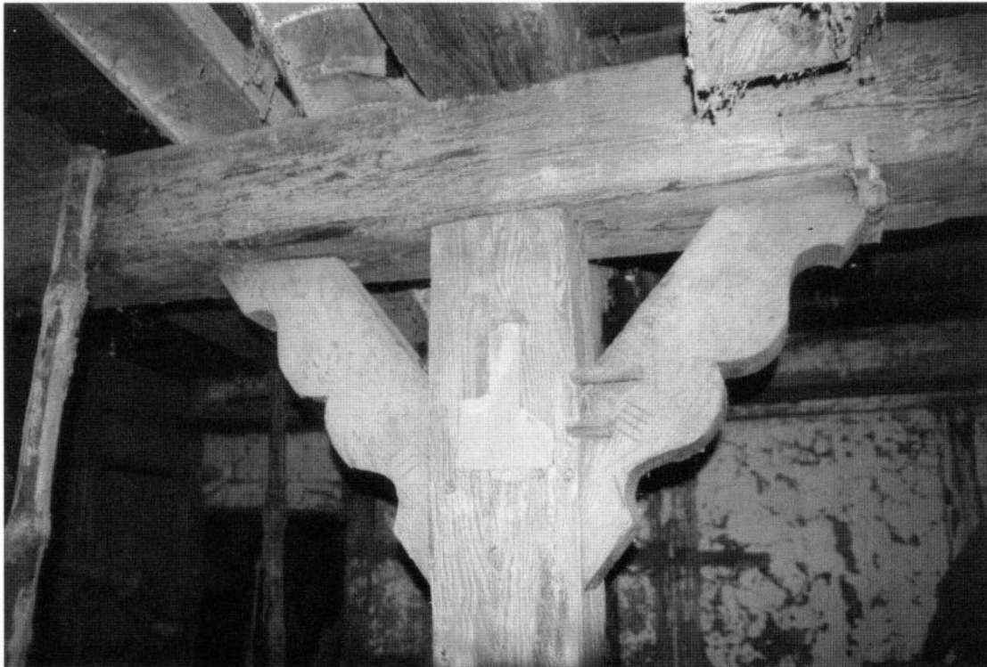
Abb. 15: „versenkt-verzapfte“ Kopfbänder am Unterzug, Dez. 2004
