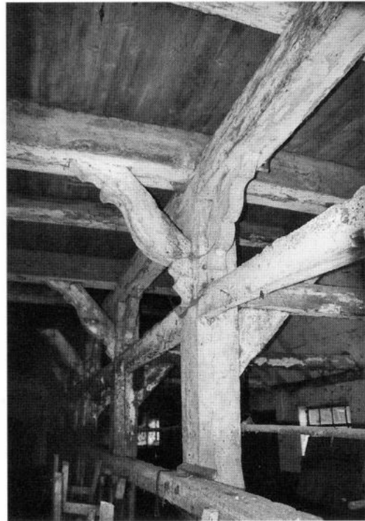
Abb. 3: Konstruktion und Verzierung des Innengerüsts, Jan. 2004
