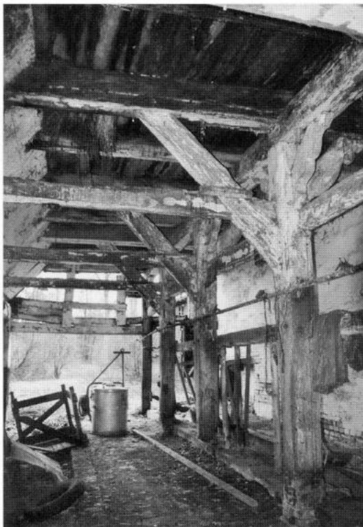
Abb. 4: Große Balkenüberstände über dem Pferdestall, Jan. 2004
