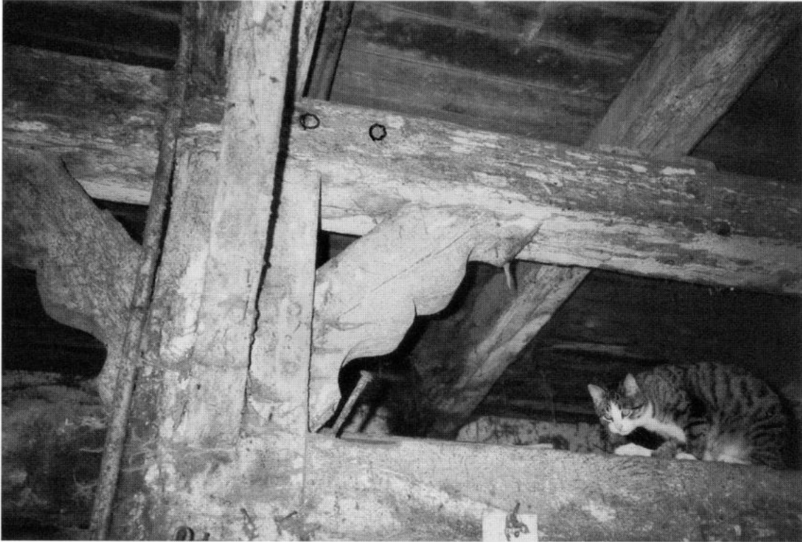
Abb. 10: Zwei „Floßbohrungen“ (nachgezeichnet) am rechten Dielerähm
